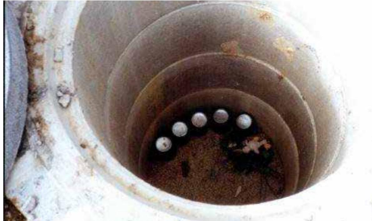
Verschlussplatte (Durchmesser ca. 30cm) auf Schachtabdeckung, verschließbar.
