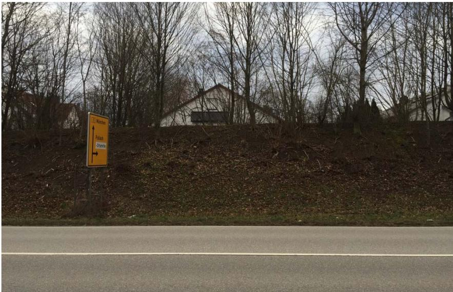
Abbildung 4. Schallschutzwall entlang der B 11.
