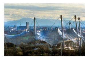
Funktioniert nach dem Prinzip des hyperbolischen Paraboloids.
