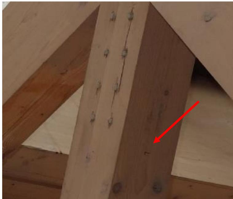
Nach DIN 4102-4:1981-03, Tab. 73 und Tab. 74, beträgt die erforderliche Mindestdicke der Holz-scheiben  $t = 20,0$  mm für eine Feuerwiderstandsdauer von F30-B.
