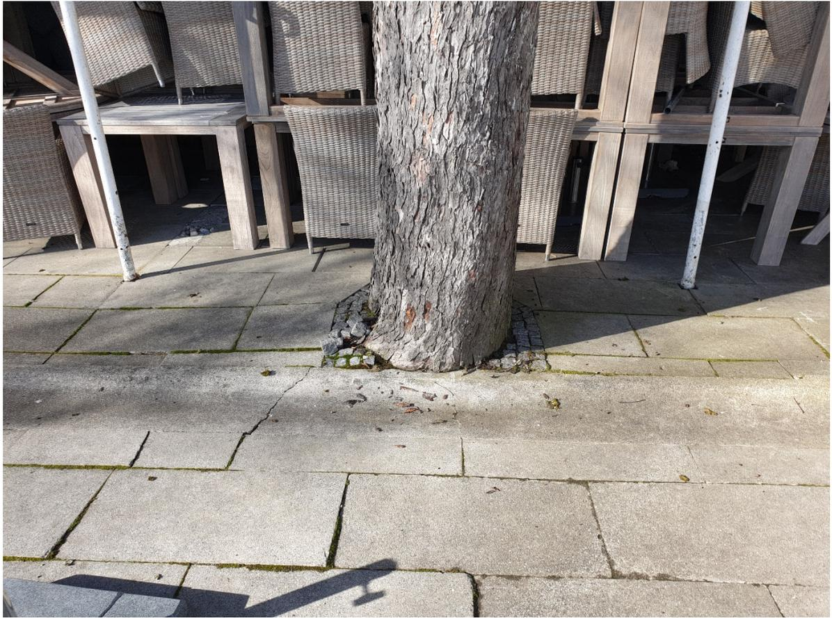
Abb. 4 und 5: Verschiebungen, Anhebungen und Risse des Terrassenbelags
