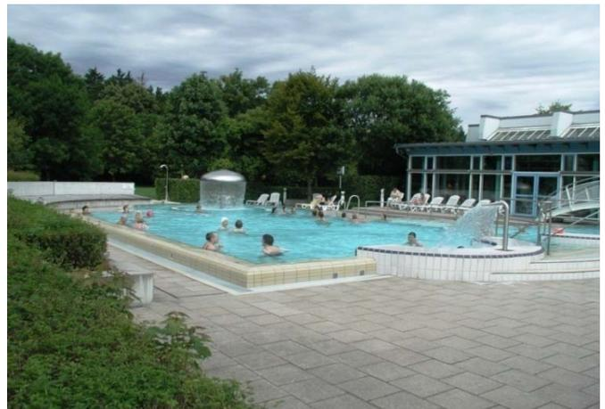
Das Becken wird mit durchschnittlich 32°C ganzjährig betrieben. Es wird über einen 1,60 m breiten Einschwimmkanal aus einer 1989 gebauten Liegehalle erreicht. Von den Beckenumgängen führen eine Beckentreppe und ein Leitertreppe in das Wasser. Die umgebenden Umgangs- und Liegeflächen sind ca. 400 m<sup>2</sup> groß. Das Außenbecken ist über ein Durchschreitebecken auch von der großen Liegewiese aus zugänglich.
